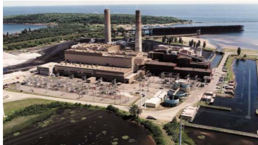
Presque Isle Power Plant, Marquette, MI
